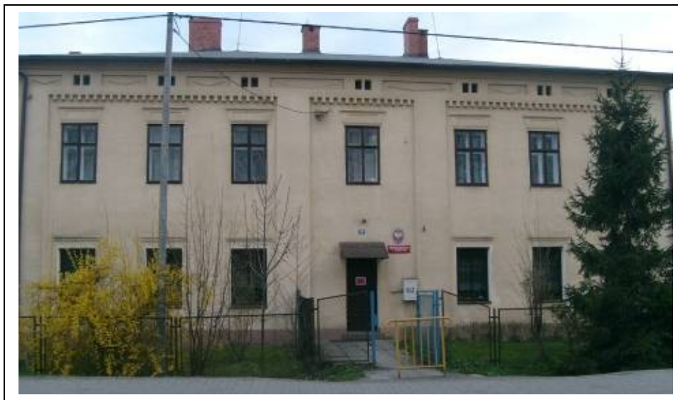
Zdj. 2. Przedszkole w Zabłociu w budynku starej szkoły z 1870r.
