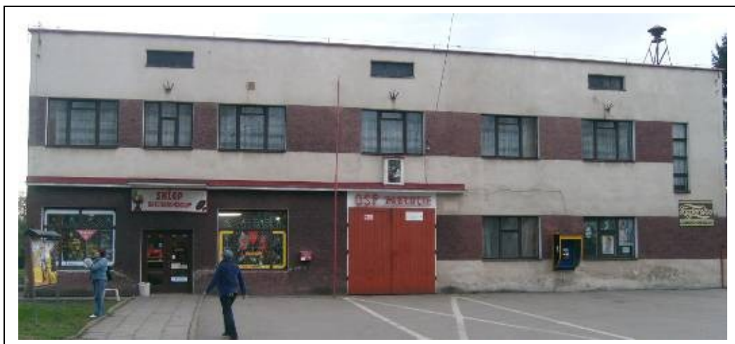
Zdj. 9. Budynek OSP w Zabłociu
