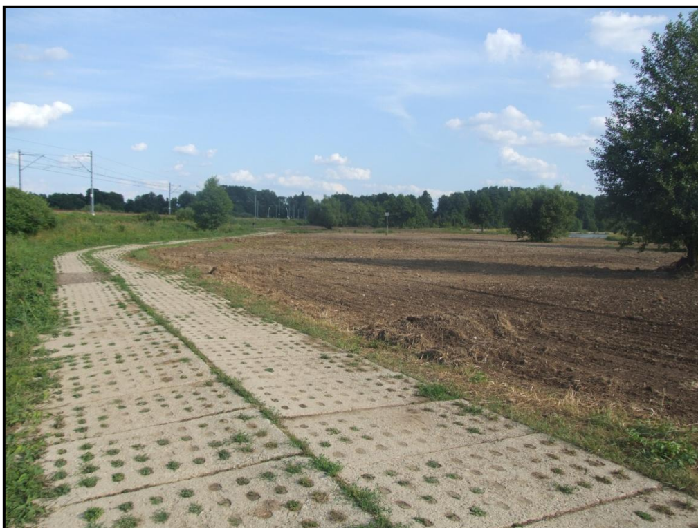
Zdjęcie nr 7. Północno-wschodnia część obszaru opracowania – widok od strony drogi wewnętrznej biegnącej wzdłuż torów kolejowych w kierunku południowym.
